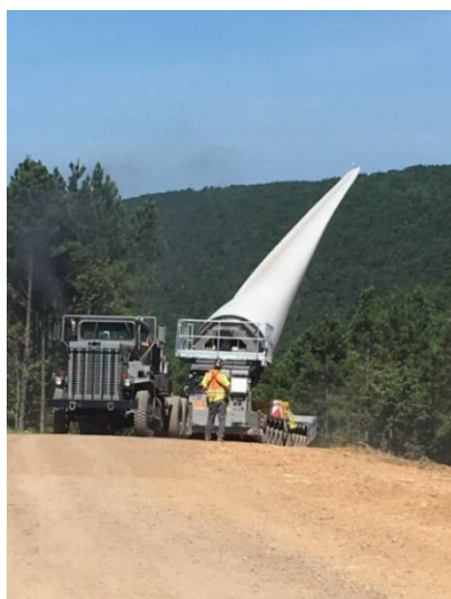
Photographie 33. Utilisation d'un Blade lifter sur un chantier de RES aux Etats-Unis ©RES »
