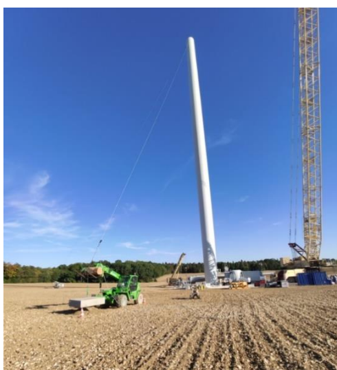
Photographie 29 : Exemple de l'installation de haubans pour stabilisation du mât (Source : RES)
